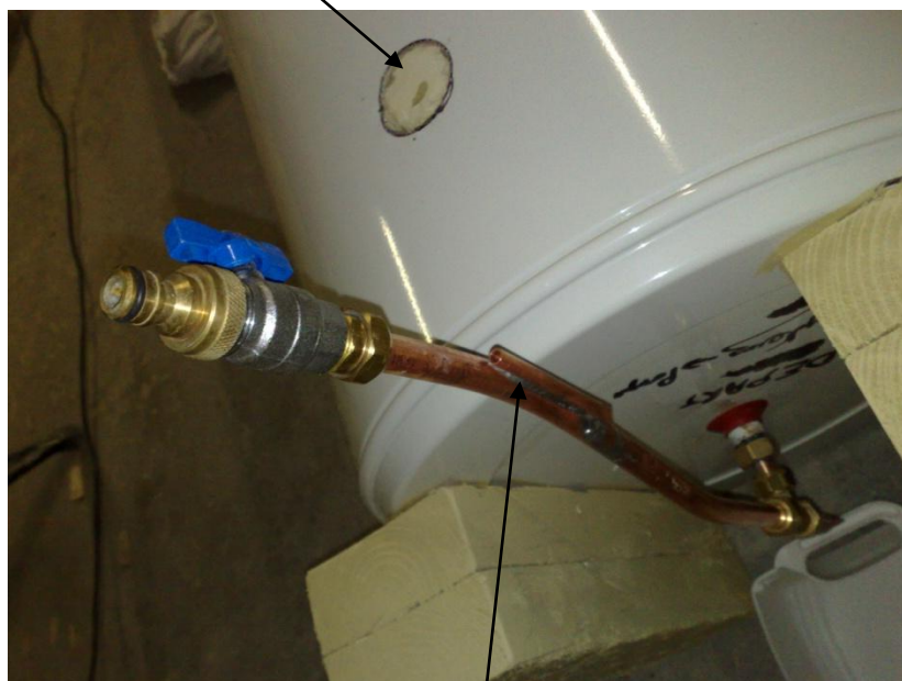
Doigt de gant sonde sortie échangeur
